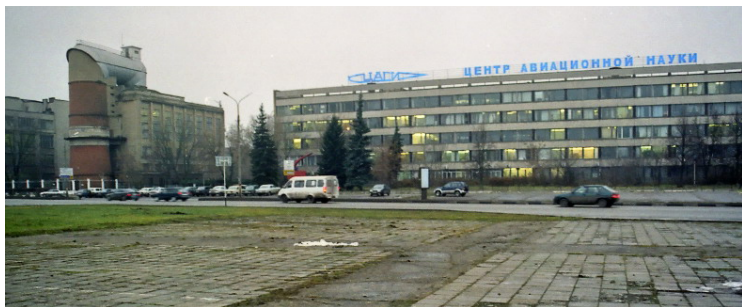
L'Institut central d'aérohydrodynamique
